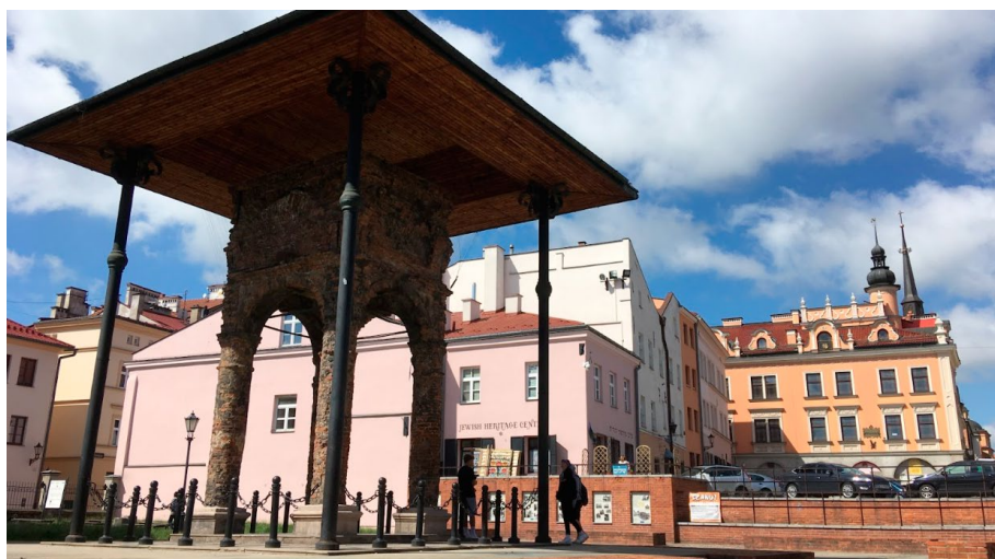
Ryc. 3. Ruiny Starej Synagogi oraz budynek Centrum Kultury Żydowskiej
