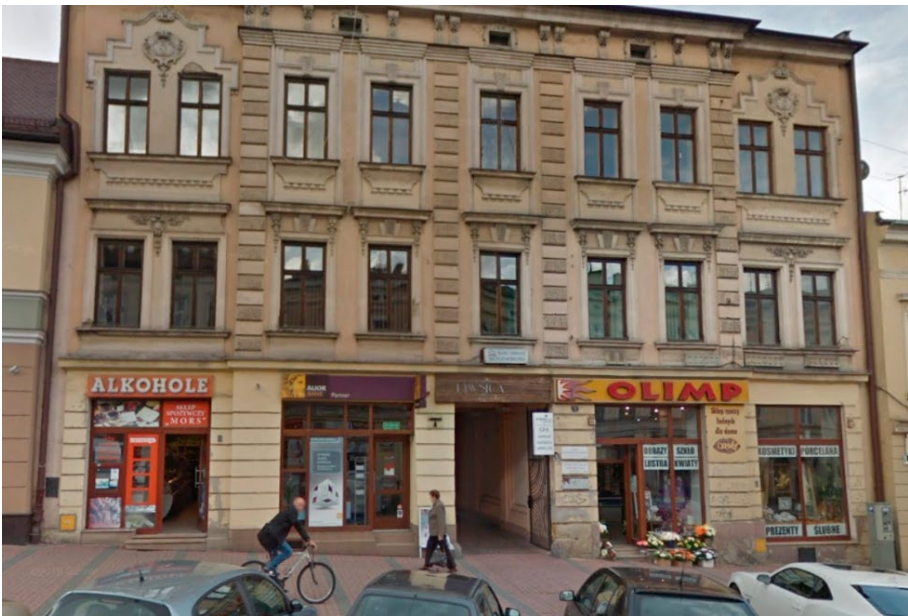
Ryc. 13. Kamienica przy ulicy Lwowskiej
